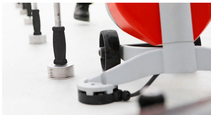
4. Zgrzanie punktów mocowania z pokryciem dachowym
