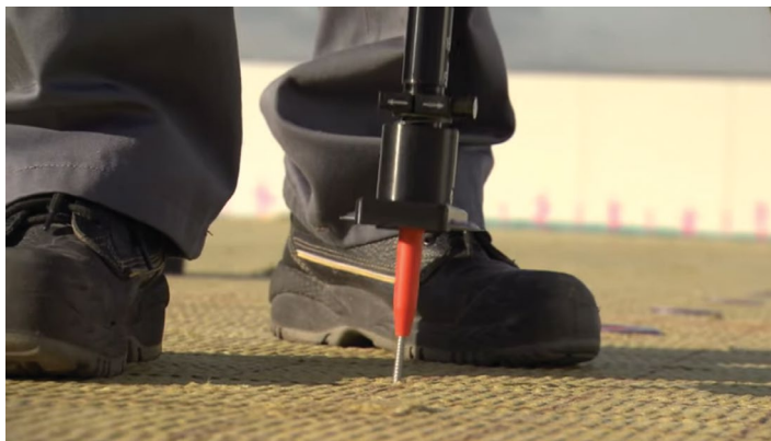
1. Montaż izolacji termicznej
